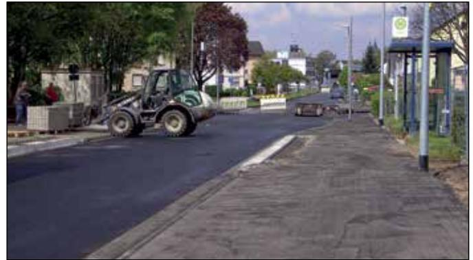
bahn wurden aufgebracht und die Pflasterarbeiten des Gehweges, der Pkw-Stellplätze und der Bushaltestelle abgeschlossen. Der Einbau der Asphaltdeckschicht erfolgt frühestens gemeinsam mit den Asphaltarbeiten im zweiten Teilbauabschnitt. Dieser wurde,
